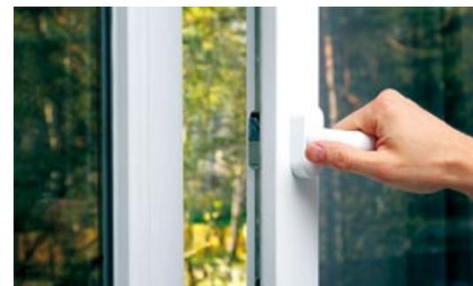
▲ Außenbauteile von Wohngebäuden, z. B. Fenster, weisen eine verminderte Schalldämmung im tieffrequenten Bereich auf.
